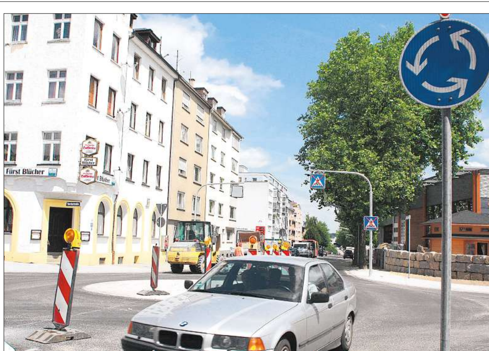
DER KREISVERKEHR in der Blücherstraße, Ecke Yorkstraße soll kommende Woche durchgängig befahrbar sein. Dann werden auch die Markierungen und die Beschilderung komplett sein. Foto: Wacker
